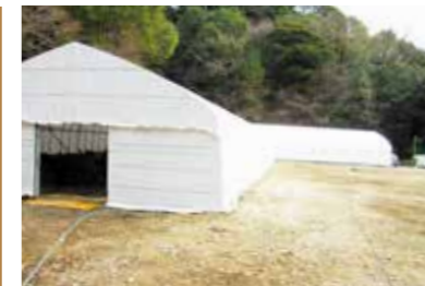
再度山作業所のしいたけハウス
